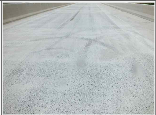
내 용 대성교(영천) 교면포장 보수
