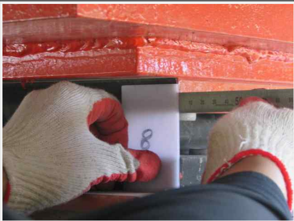
P2 교량반침 이동량 측정(상주)
