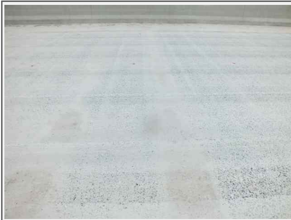
내 용 대성교(상주) 교면포장 보수
