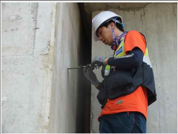
하부구조 탄산화깊이 측정
