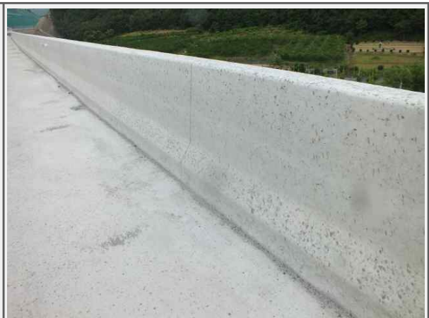
내 용 대성교(영천) 방호벽 보수
