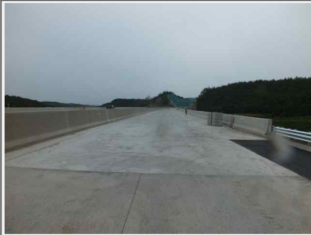
내 용 대성교(영천) 상부
