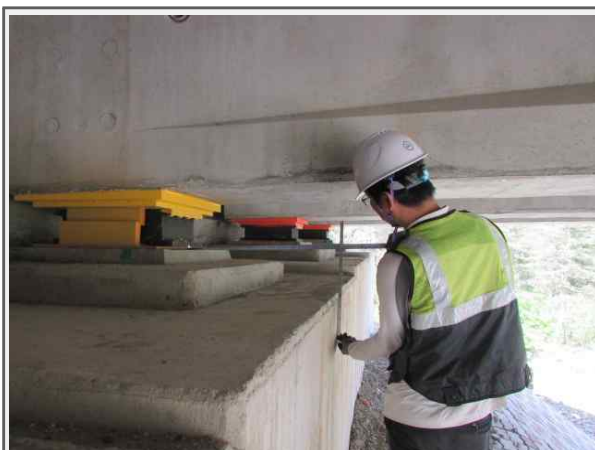
A1 연단거리 측정(상주)
