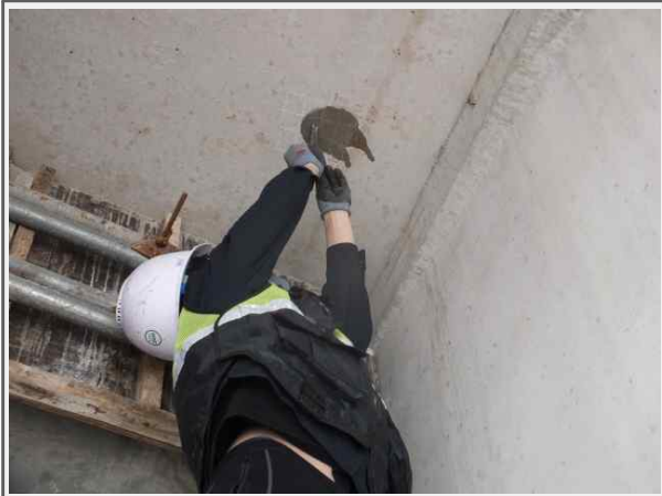
상부구조 탄산화깊이 측정
