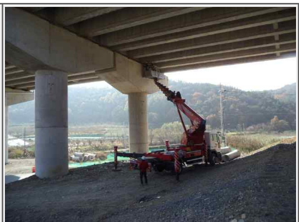
내 용 대성교(영천) 교각 보수
