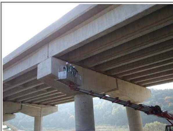
내 용 대성교(상주) 교각 보수
