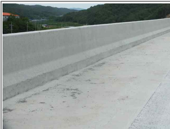
내 용 대성교(상주) 방호벽 보수
