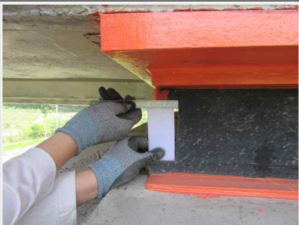
A1 교량반침 이동량 측정(상주)
