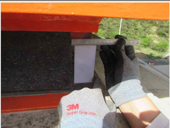
A1 교량반침 이동량 측정(영천)
